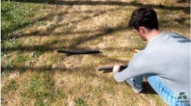
9) Découper l'extrémité du déflecteur en laissant 10 cm de plus que la longueur totale de mousse pour permettre sa fixation autour du tronc.
